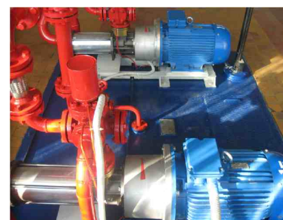
МНУ после реконструкции
